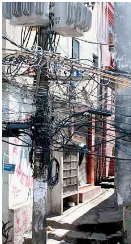
Figura 10: Exemplo de um “gato” de eletricidade.
